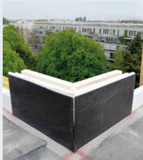
Ecken werden in Gehrung geschnitten.
