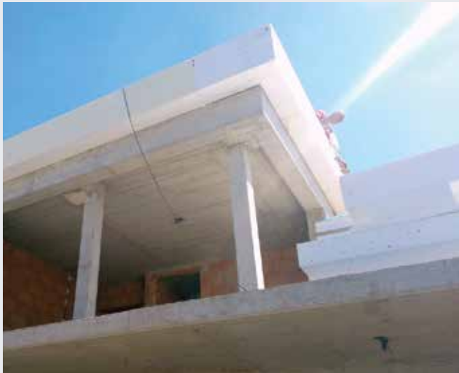
Anwendung auf Betondecken.
